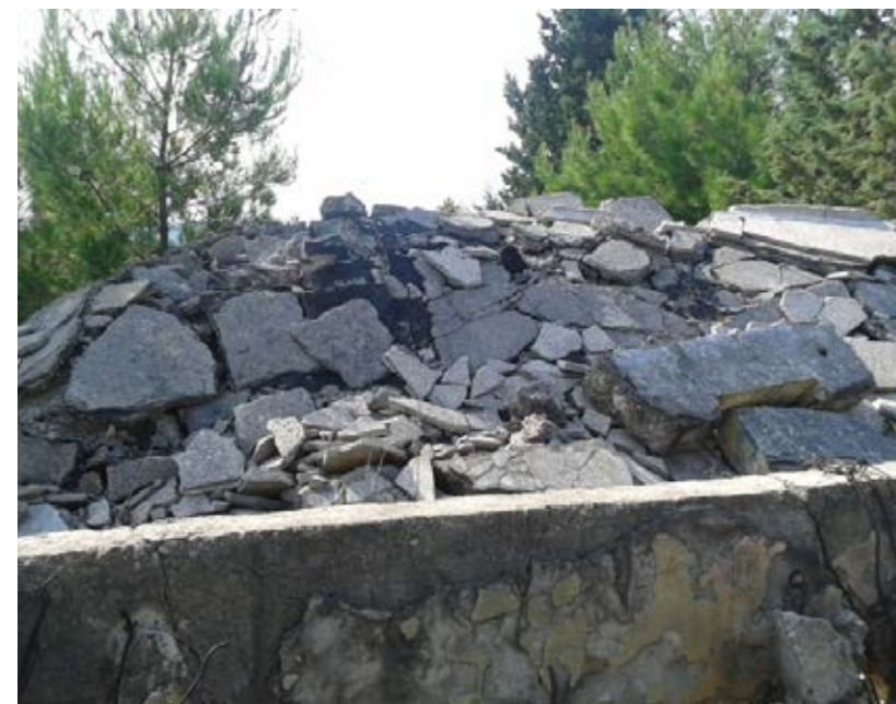
Slika 4. Prikaz ruševine zgrade
