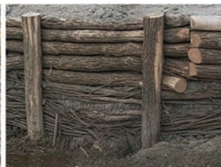
3.c Potporni zid
