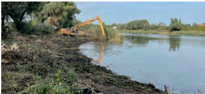
Slika 5. Čišćenje vegetacije na desnoj obali tijekom treće faze (autor fotografije: Hrvatske vode)
