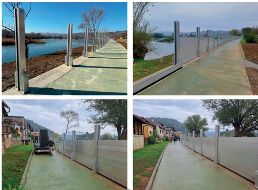
Slika 4. Postavljanje montažnog protupoplavnog sustava - Hrvatska Kostajnica, ožujak 2024.
