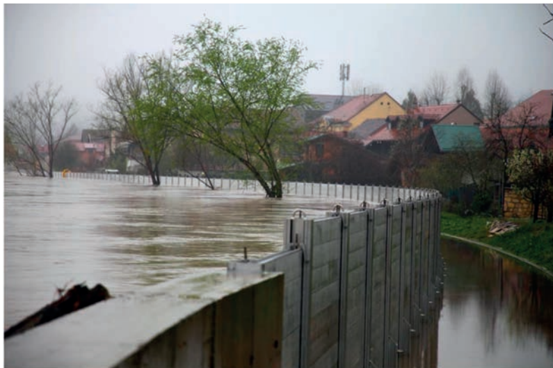
Slika 5. Montažno - demontažni sustav u svojoj punoj funkcionalnosti - Hrvatska Kostajnica, ožujak 2025.
